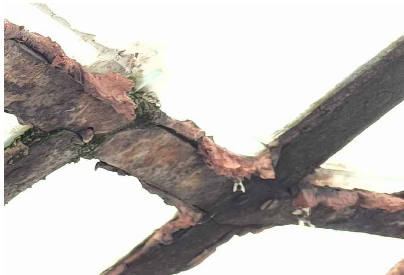
FOTO č.3 – VÝMĚNA KROKVÍ Z INTERIÉRU
